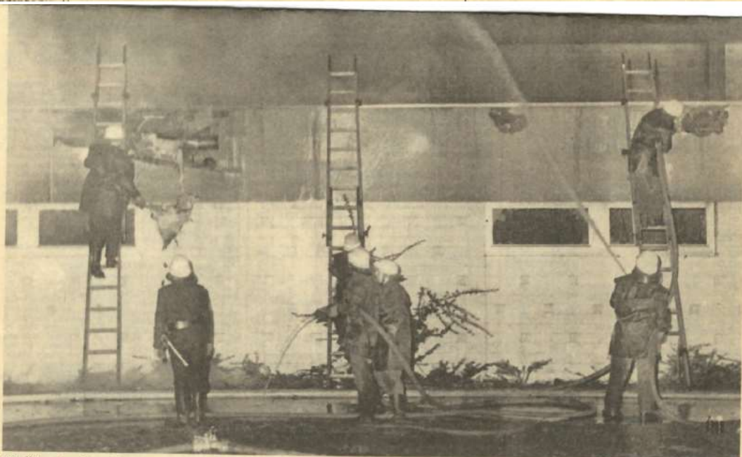
Mit Äxten hackten Feuerwehrleute die Zwischendecke auf, um den Brandherd wirksamer bekämpfen zu können. Feuerwehrmänner berichteten, daß dies bisher der drittgrößte Einsatz für die Garbsener Wehren und das größte Schadenfeuer in Garbsen überhaupt war.
